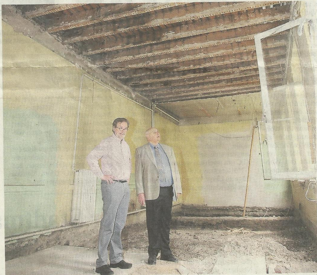
Hansgeorg Hauser (r.) und Architekt Jürgen Schwittmann begutachten den früheren Konfektionssaal im Erdgeschoss, wo die gewebten Stoffe genäht wurden. Hinten beginnt ab dem Mäuerchen der zuletzt angebaute Teil des Hauses – ohne Fundament.
